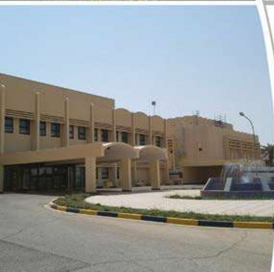
Usine de Médicaments «Spimaco» (Al Kassim - Arabie Saoudite) مصنع أدوية «سبيماكو» (الفصيم - العربية السعودية) Pharmaceuticals Factory «Spimaco» (Al Kassim - KSA)
